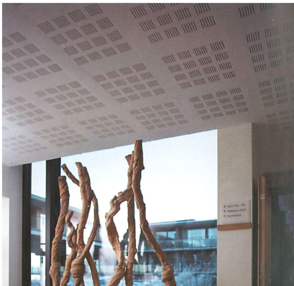
Obr. 6: Ukázka instalace SDK podhledu Rigips Gyptone Big Line 6 pod stropem prostoru
